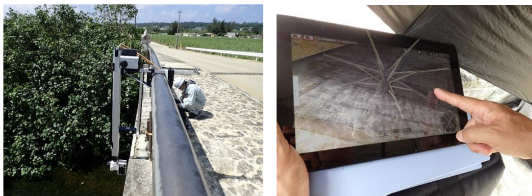
写真-2 ロボット点検による橋梁点検の状況
