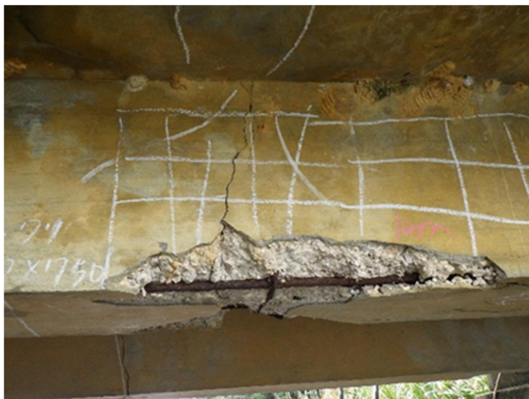
写真-1 橋梁の損傷事例（真玉橋）
