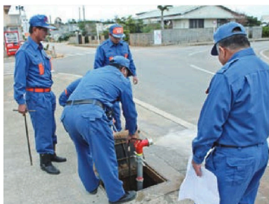
↑ ア 消防しせつの点検
