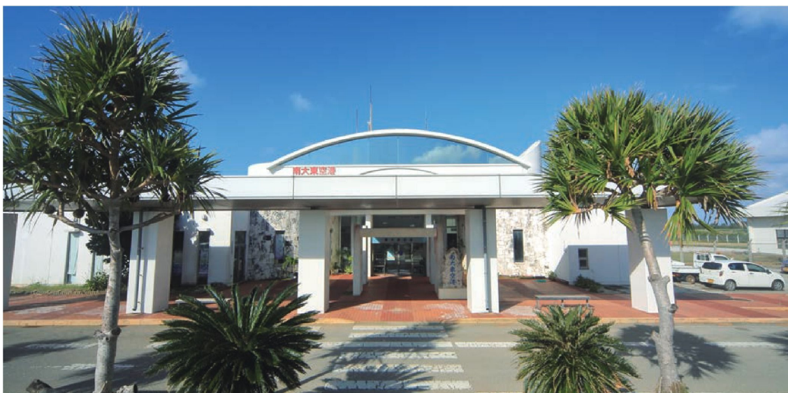
↑ 新しくつくられた南大東空港
